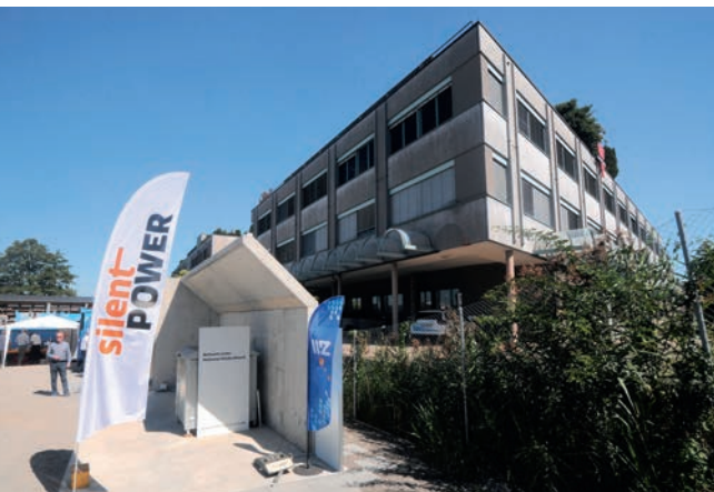
Brandschutzmauer für den vorgesehenen Methanol-Tank mit 22 500 Liter Inhalt. Rechts das Gebäude der Wasserwerke Zug WWZ, das mit dem ersten Econimo beheizt wird.
